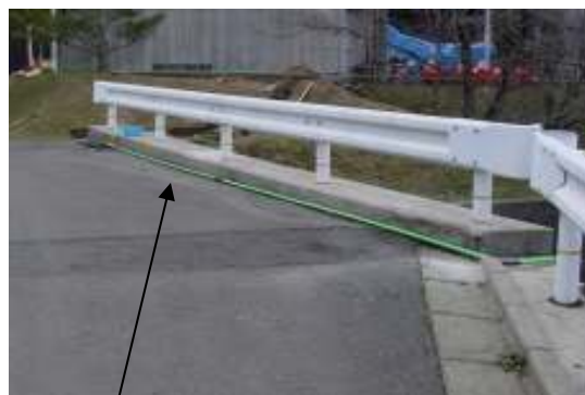
送油管（最終的には埋設した）
