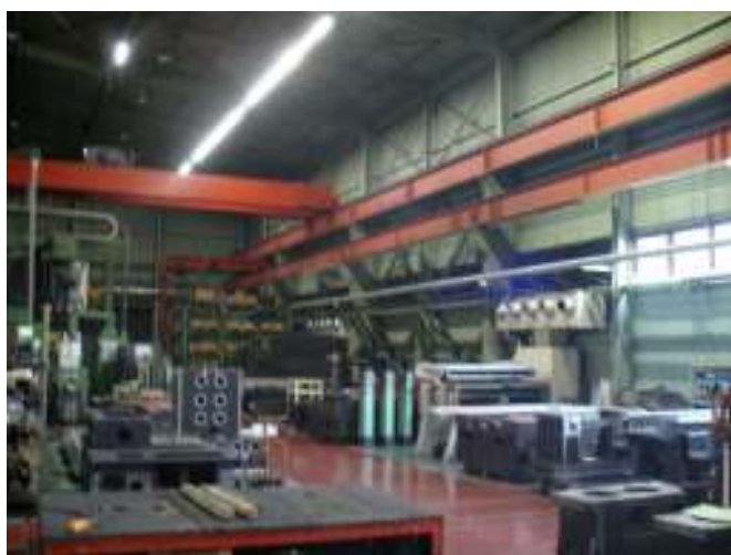
無電極水銀灯に交換前（蛍光灯）
