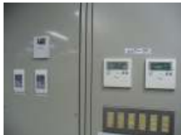
ウイクリータイマーによる空調機制御
